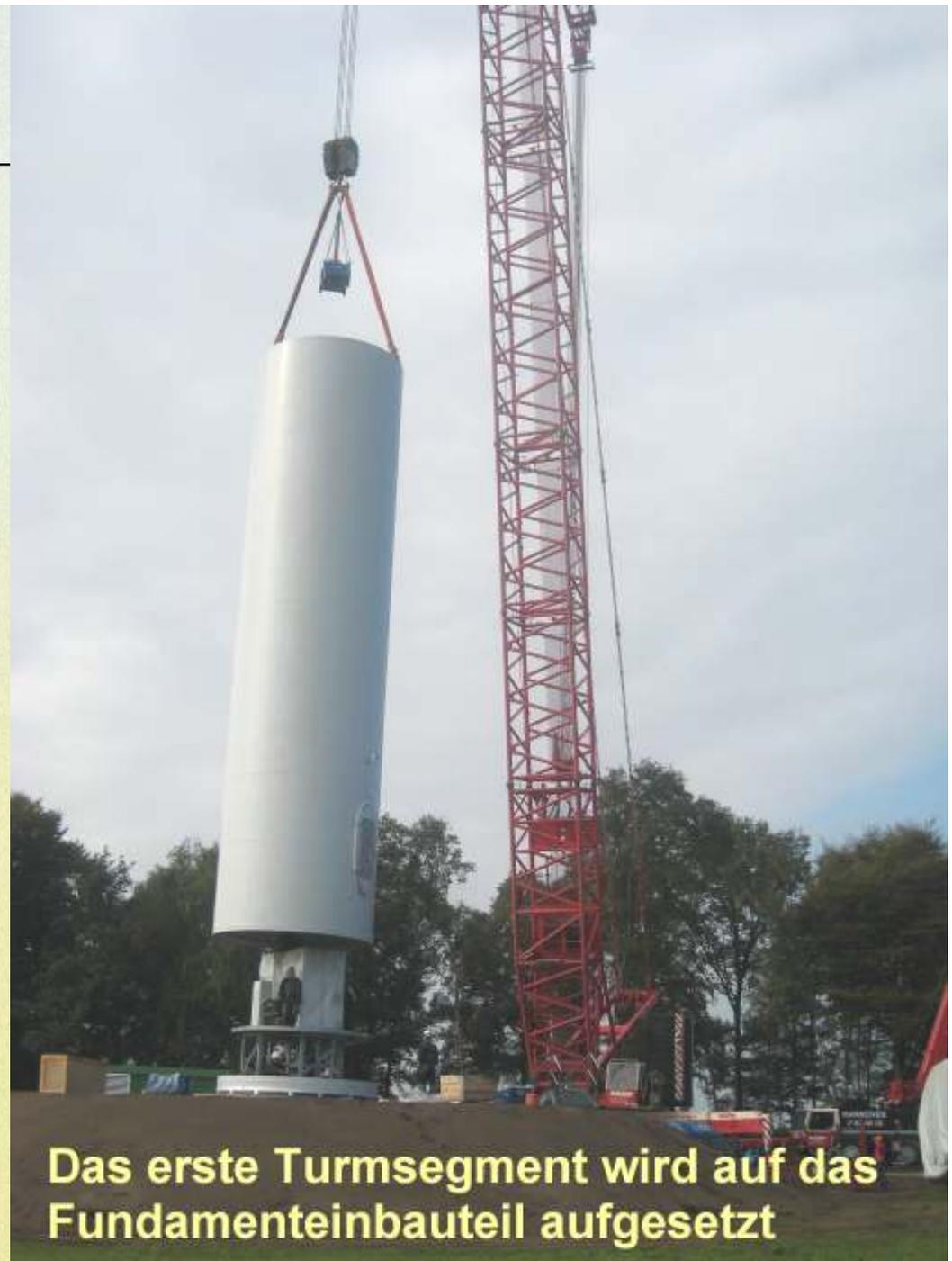
**Das erste Turmsegment wird auf das Fundamenteinbauteil aufgesetzt**
