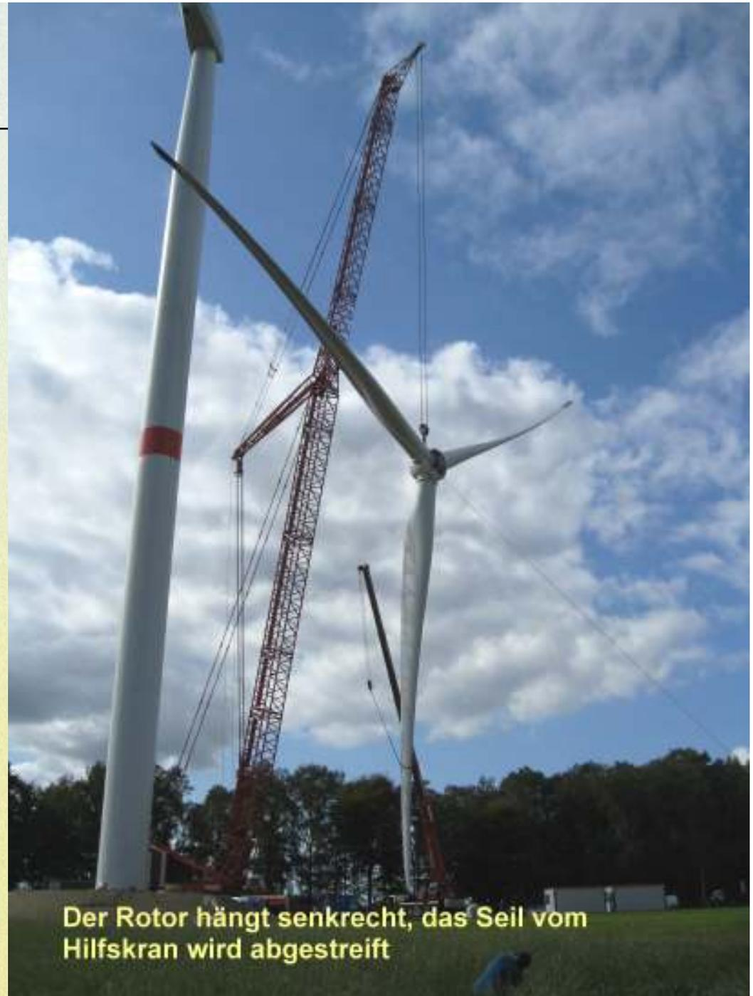
Der Rotor hängt senkrecht, das Seil vom Hilfskran wird abgestreift
