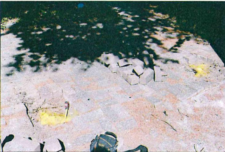
Wird der Erhalt der drei Straßenbild prägenden Linden angestrebt, so sollten die Pflasterbeläge im Bereich der starken Verwerfungen entnommen werden und die hierbei entstehenden Pflasterlöcher niveaugleich z.B. mit Compomac Kaltasphalt verfüllt werden. So lassen sich für die kommenden Jahre die hohen Stolperkanten beseitigen, ohne die Starkwurzeln kappen zu müssen. Dieses Vorgehen setzt jedoch das Einverständnis der Anlieger voraus.
