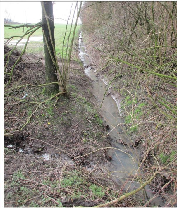
Abb. 6: Graben am Dammfuss der L 555 in den eingeleitet werden soll
