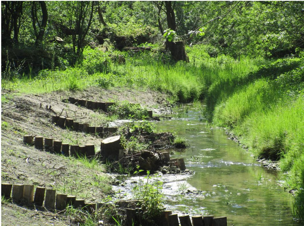
Abb. 12: Pfostenreihen zur Rückhaltung und Schilfförderung; die Pfosten lassen dann nur wenige Liter/Sekunde passieren und wirken als Drossel
