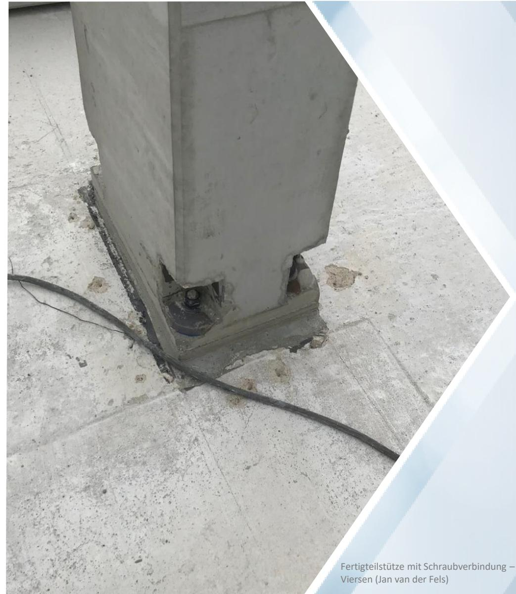
Fertigteilstütze mit Schraubverbindung – Kreis
